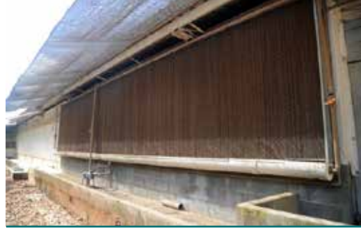
Figura 12. Sistema de pressão negativa: painel evaporativo.
