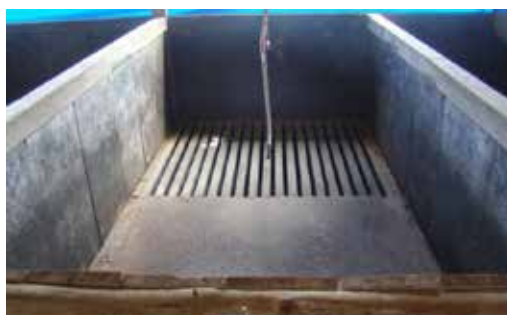
Figura 36. Baia com piso compacto (70%) e ripado (30%).
