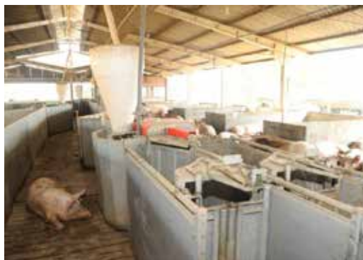
Figura 9. Estações eletrônicas de alimentação sobre piso ripado de concreto
